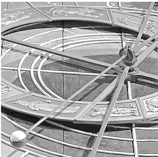
Detalj av månvisaren med klotet som roterar i en skål. Halva klotet är vitt och halva svart. Foto Eric Read 15-04-01.
