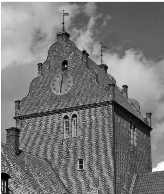
Urtavla mot borggården. Dagens tornur är levererat av Linderoth 1908. Klangskålen skymtar mellan vimplarna lodrätt ovanför takåsen på samma plats som Bäckström föreslagit. Foto E. Read 2012-08-23.
