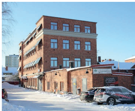
Bild 8. Byggnaden Eskilsgatan 20 idag. Foto Anders Eriksson.
