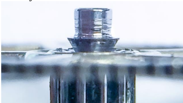
Detalj av centrumhjulets slitage.
