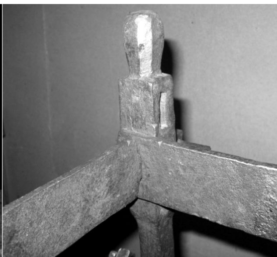
Figur 3 Hörnstolpe med infästning av den övre plattjärnsramen. Det övre hålet i stolpen har antagligen tidigare använts för ett plattjärn som suttit utmed verkets långsida.
