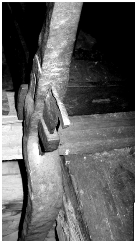
Figur 3 Hörnstolpe med infästning av den övre plattjärnsramen. Det övre hålet i stolpen har antagligen tidigare använts för ett plattjärn som suttit utmed verkets långsida.
