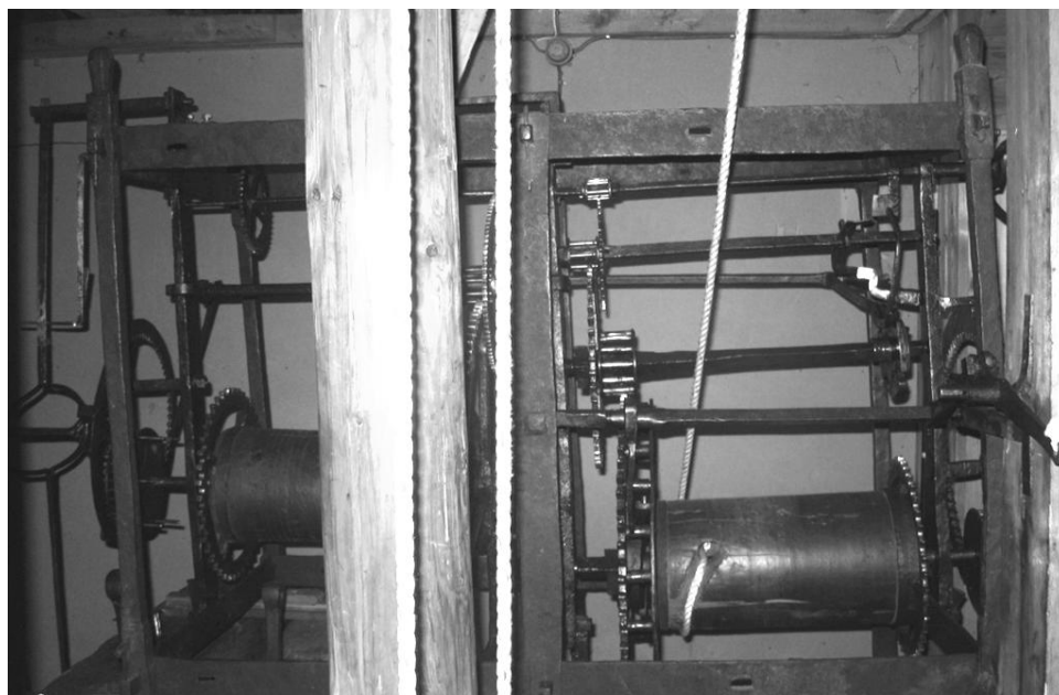
Figur 2 Rådhusets tornur med gångverket till vänster. Hörnpelarna och linvalsar med kugghjul är troligen från 1500-talet.
