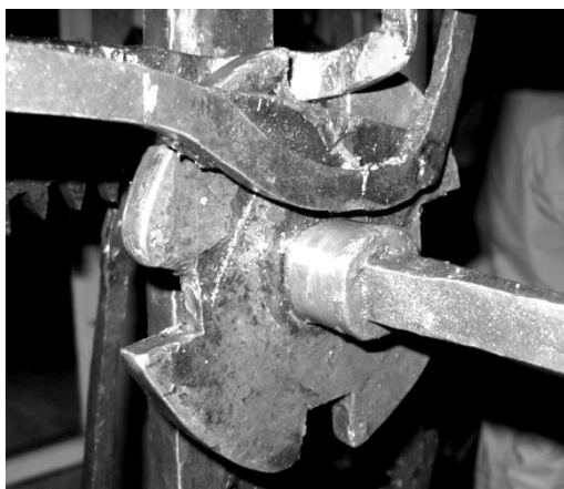
Figur 13 Hjärtat som ursprungligen har haft ett urtag, har senare försetts med fyra urtag.
